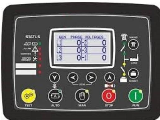
Le contrôle commande est équipé d'une carte avec microprocesseur pour commande, contrôle, mesure et protection du groupe électrogène.
